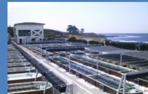
魚類・貝類種苗生産施設
