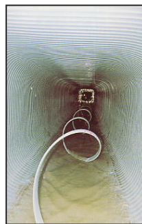
管渠耐震化工法(更生工法の採用)
