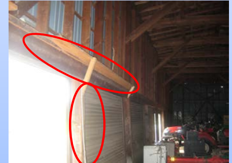
柱・梁の歪みの補修、補強
