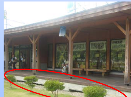
沈下した基礎部の補修、補強
