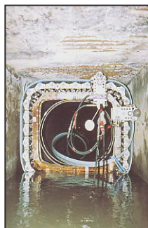
管渠耐震化工法(更生工法の採用)
