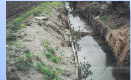
老朽水路の改修
