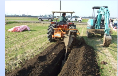
暗渠排水の設置
