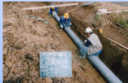
農業用水路の設置
